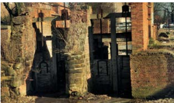
't Saske te Aarschot (Staf De Roover, 2005) Jarenlang stond het oude sluisje dat het waterpeil van de vesten regelde, te verkommeren.
